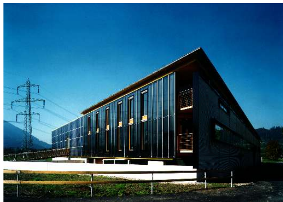
Thermisches Müllverbrennungs- / Photovoltaik-Kraftwerk
